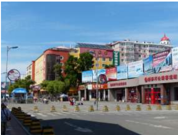
国境の町・綏芬河（ロシアとの貿易が盛ん）道路沿いの建物
