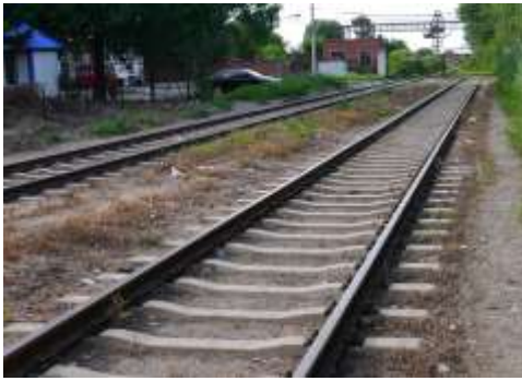
外と繋がり多面的な利用をした鉄道列車線路
