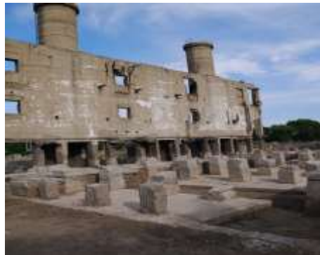
全館を暖房したボイラー跡
